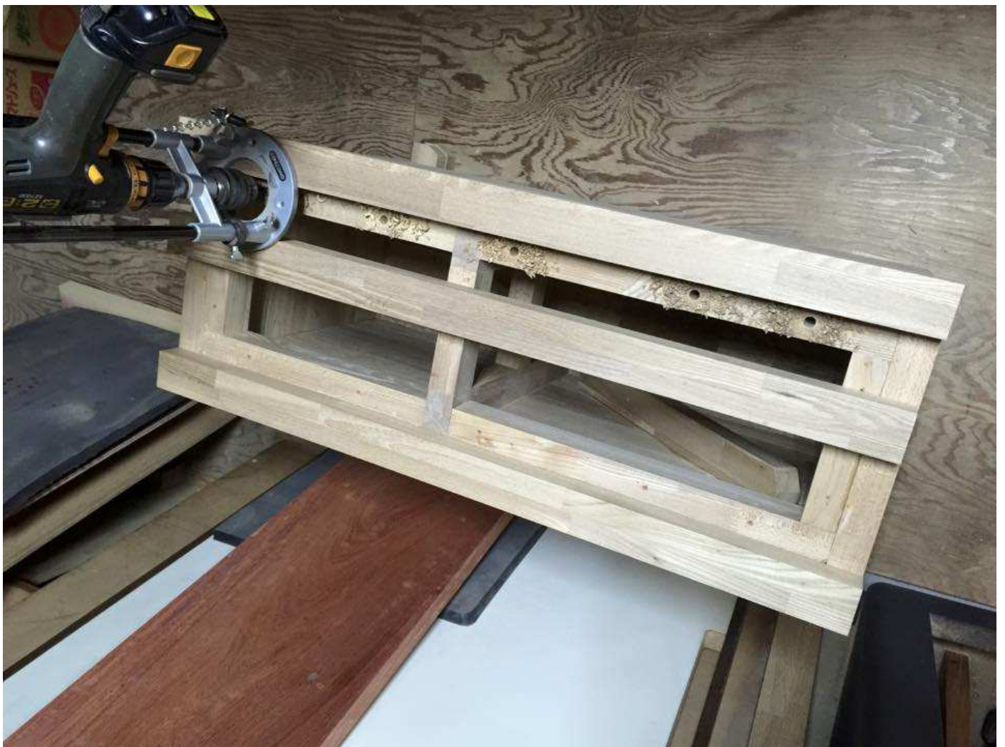
■ バッフル取付穴の加工
