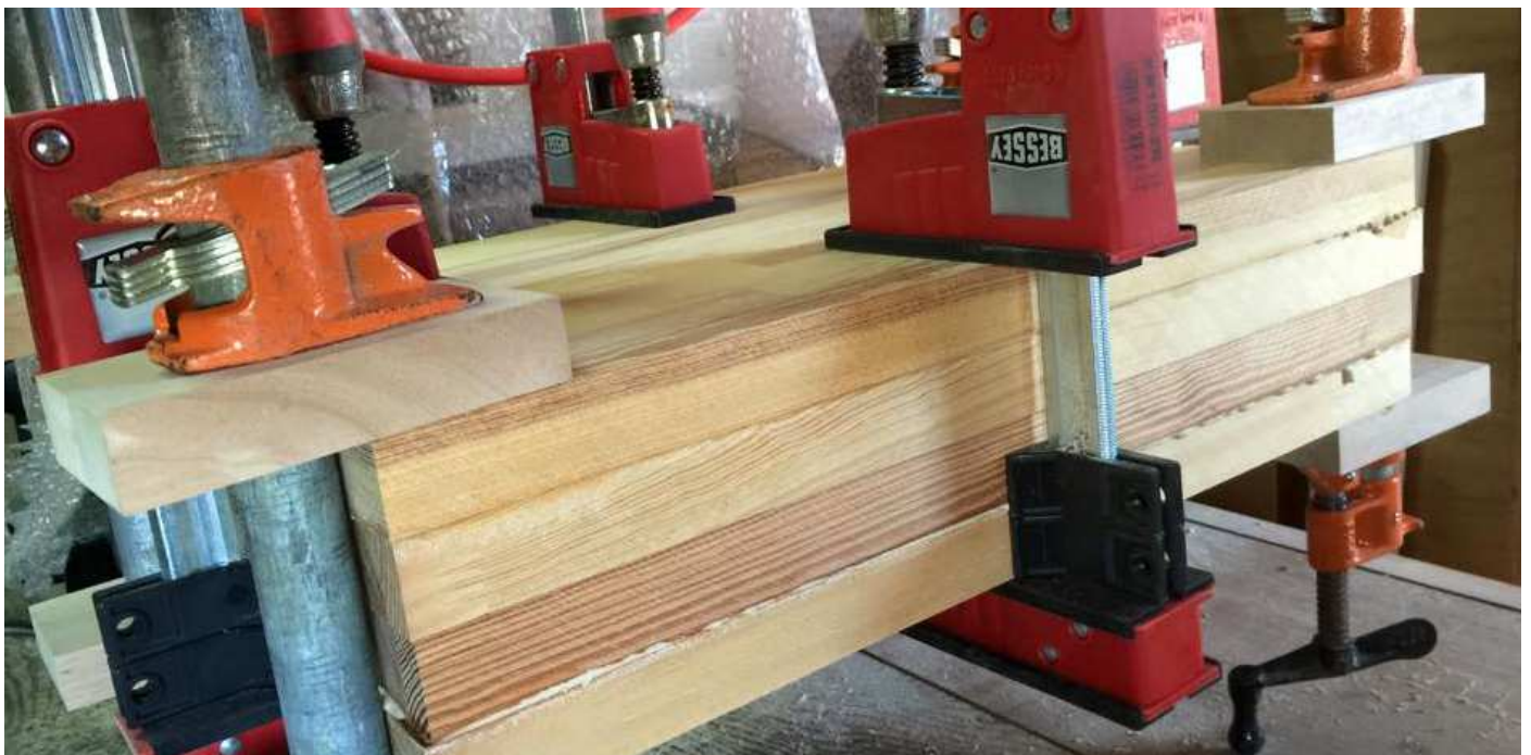
■ 28日～ SP-BOX の置き台用座板の加工
