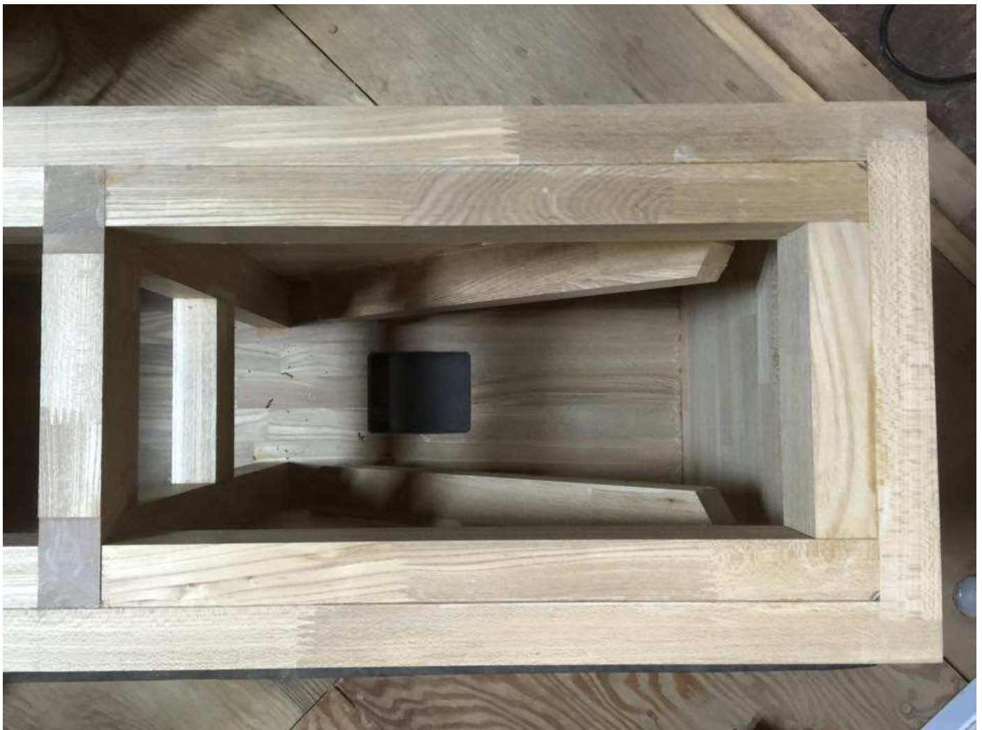
■ 補強材を取り付けた BOX 内部
